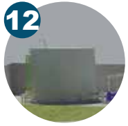
12 Reservatório de água de potavel Armazena água para consumo e outros usos de contato primário
