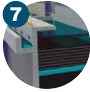
7 Decantador de Alta Taxa (lamelar) Clarifica o efluente tratado
