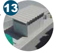
13 Centro de controle de motores Sala que reúne todos os painéis elétricos
